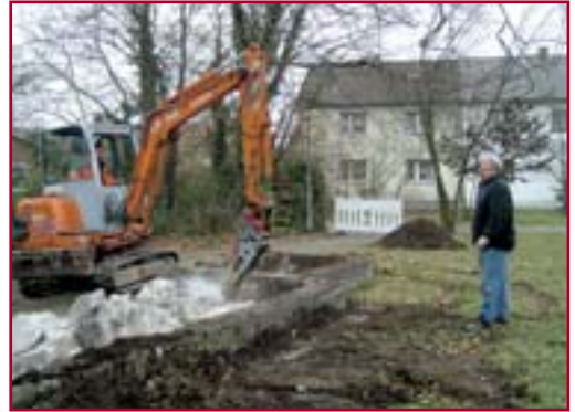
Arbeiten am Hambacher Platz.
