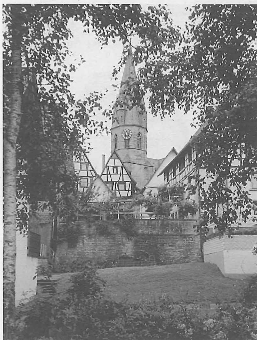
Der Turm der katholischen Kirche überragt die Bauwerke in der Altstadt.
