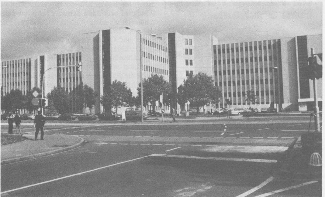
Das sechsgeschossige Betriebsgebäude von Siemens.
